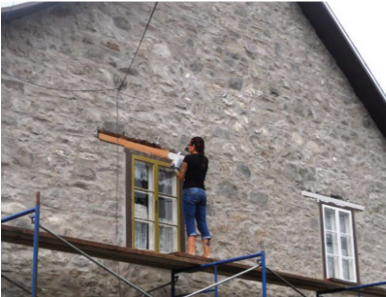
Échafaudage pour la restauration d'une maison construite vers 1830, à Beaupré.
