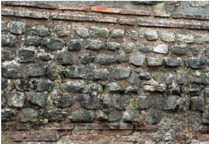
Mur de la Rome antique constitué de pierres et de briques reliées par un mortier de chaux et de cendres volcaniques appelé « béton romain ». Photo Wikipedia.
