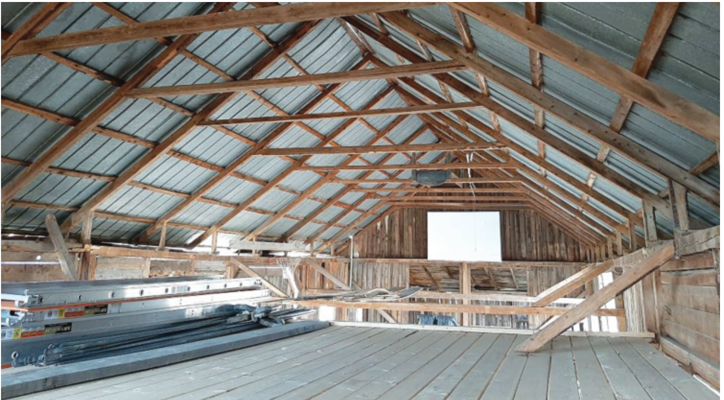
Des travaux de toiture en cours en novembre 2021.
