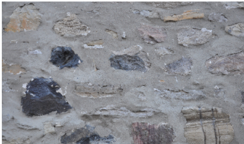
Photo 2 – Moellons de composition granitique (noirs, rosés, blancs) et de moellons composés de dolomie (chamois) provenant de la moraine (till). Maison du bedeau, 1859, Vieux Sainte-Rose, Laval.
