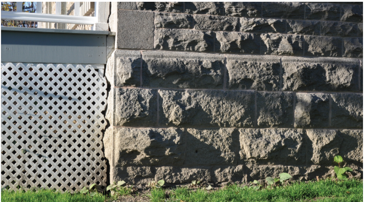
Photo 5 – Fondation en pierre de taille, pierre grise de Montréal. Maison Ouimet, 1900, Laval.
