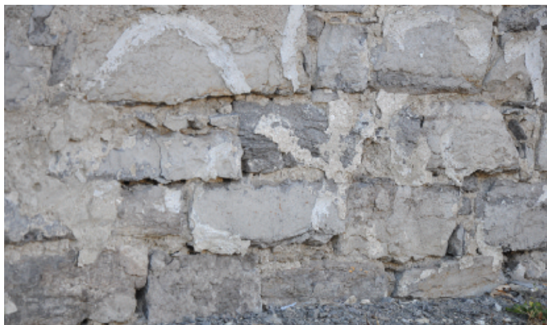
Photo 3 – Fondation construite de pierres du roc de surface, calcaire à grains fins, légèrement argileux. Maison Labelle, vers 1750, Laval.
