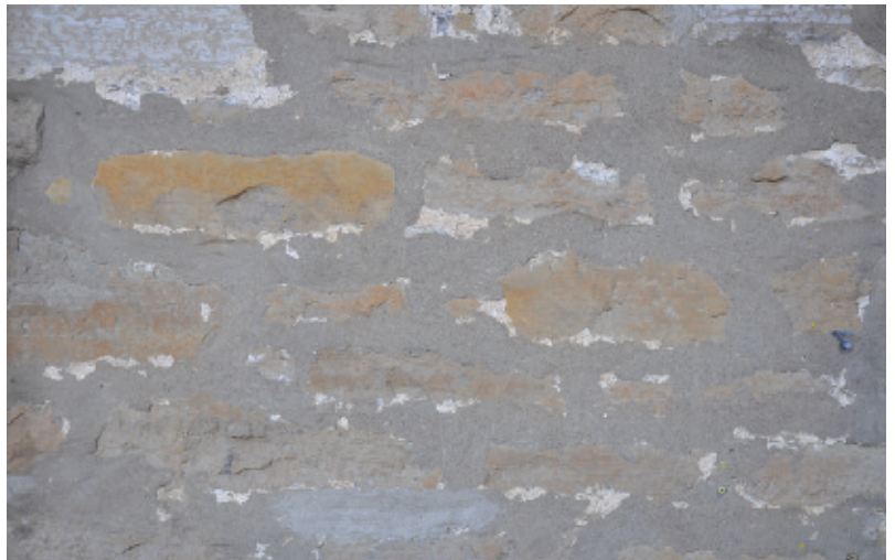
Photo 4 – Altération caractéristique, couleur chamois, de la dolomie (calcaire magnésien) grise en cassure fraîche. Vieux Sainte-Rose, Laval.
