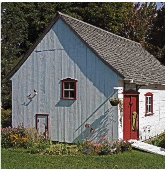
Photo 6 prise après la restauration: Hangar situé à l'arrière de la maison et de la grange.
