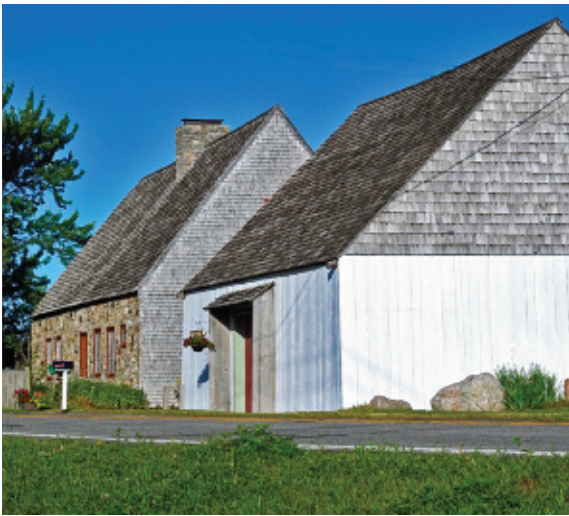
Photo 5 prise après la restauration : Grange ou remise munie de structure à la française, placée dans l'axe de la maison.
