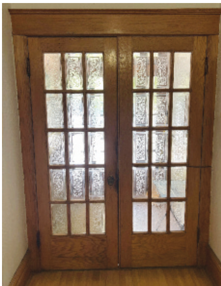
Portes intérieures du vestibule de l'accès principal munies de carreaux de verre ciselé.
