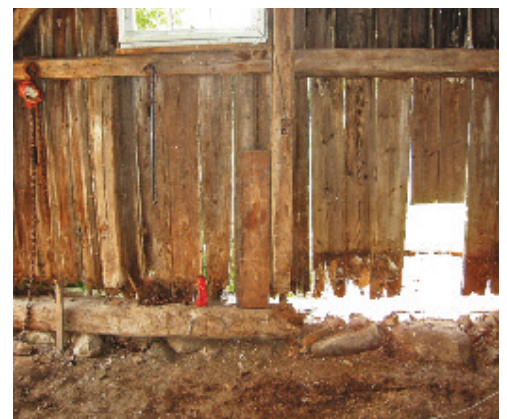
Photo 3 prise en 2008 lors des travaux de restauration : Vue du hangar, état du solage de pierre sèche, de l'ossature et des planches du pignon ouest.
