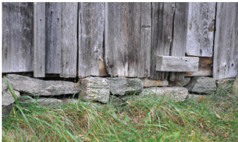
Photo 1 – Fondation en pierres sèches (non cimentées). Remise, tournant des XIX e et XX e , Brownsburg.
