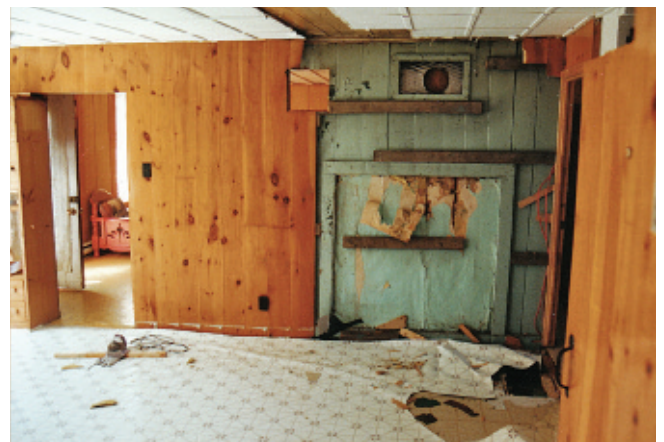
Photo 3 – Salle à manger de la maison Pichet-Gosselin lors des travaux.
