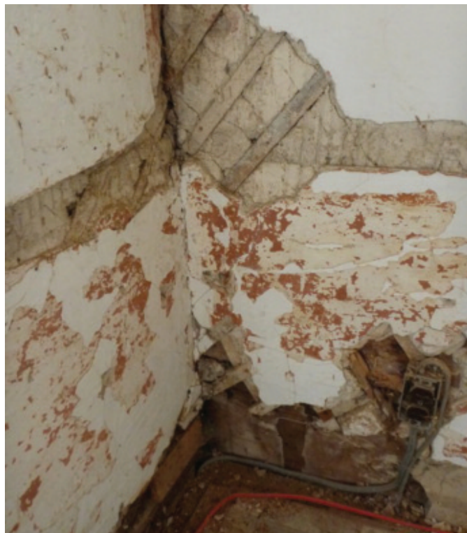
Photo 5 – Mur de lattis avec enduits et badigeons ocre rouge, maison Pichet-Gosselin.
