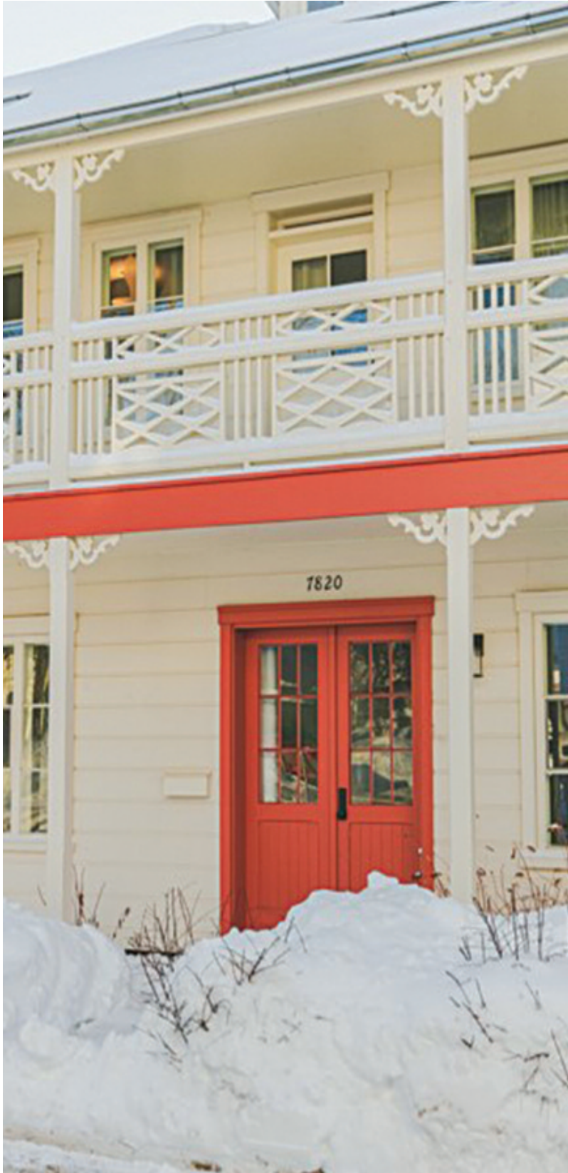
Les composantes anciennes participent à la richesse des façades sur rue.
